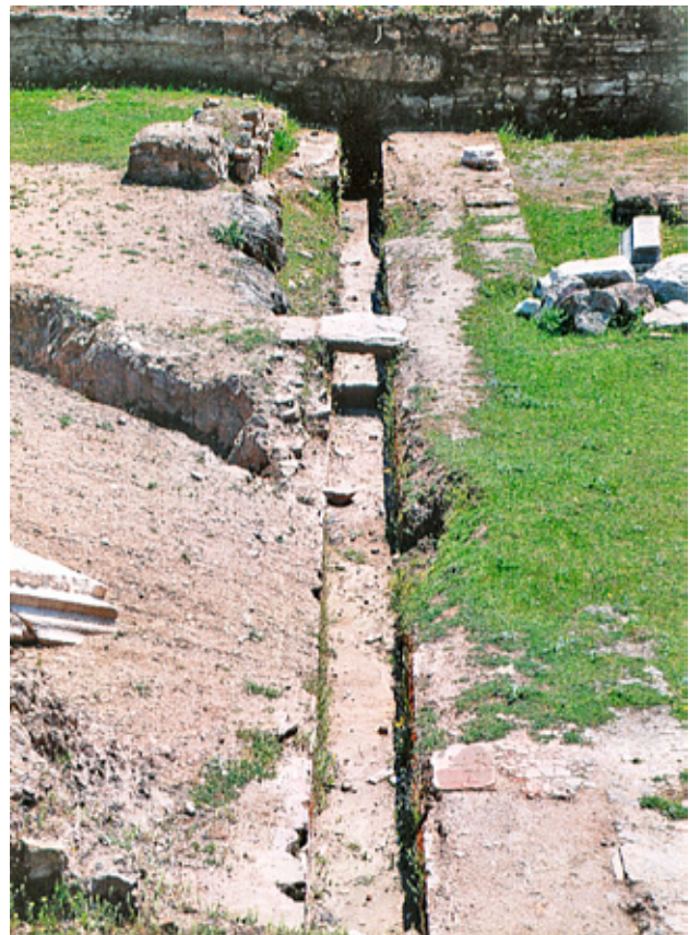
Сл. 33 Канал за довод на студена вода во фригидариумот.
